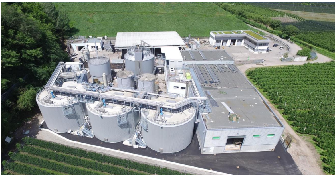
Abbildung 12: Beispiel einer Vergärungsanlage für feste und flüssige Abfälle nach FITEC-Technologie
